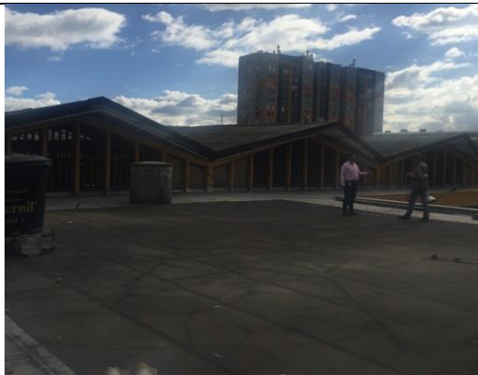
Impermeabilización de cubierta no ejecutada
