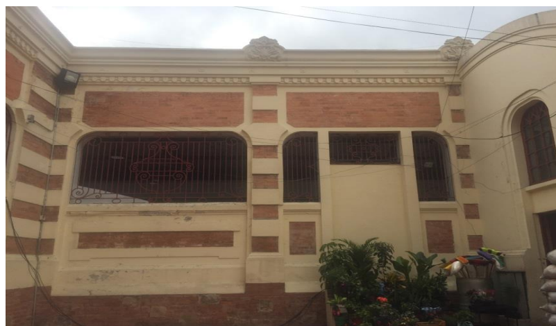
Impermeabilización de canales no ejecutada
