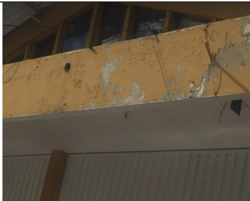
Pintura antihumedad deteriorada
