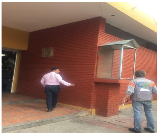
Menores cantidades en lavado de fachada
