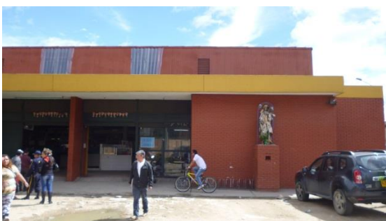
Menores cantidades en lavado de fachada
