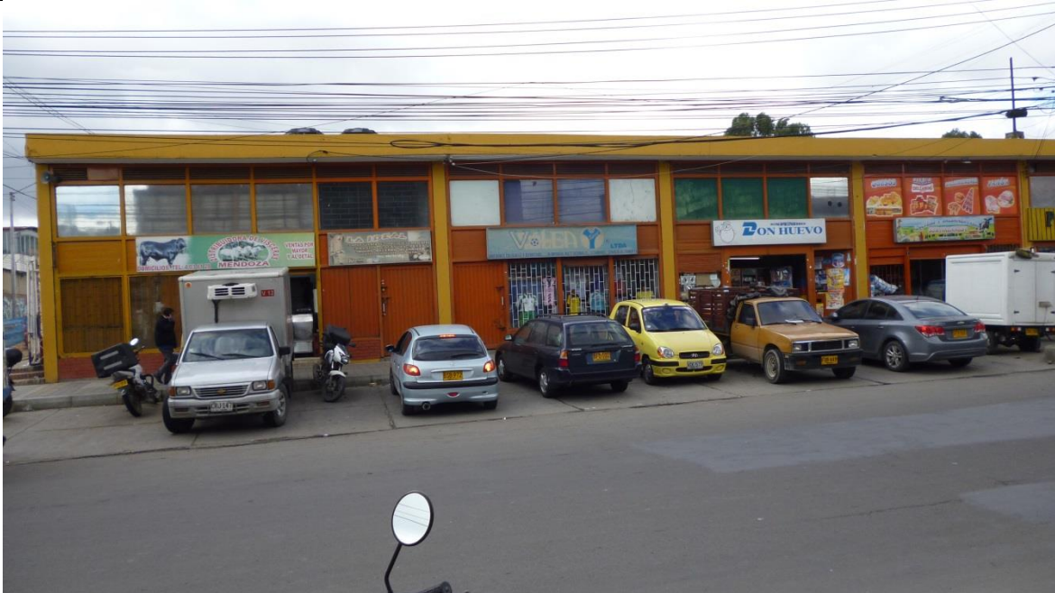
Mediciones de pintura en fachada principal
