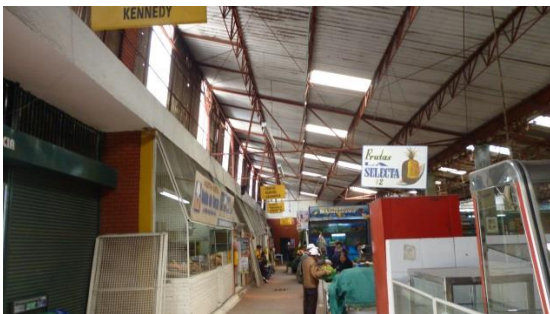
Mantenimiento de cubierta no ejecutada
